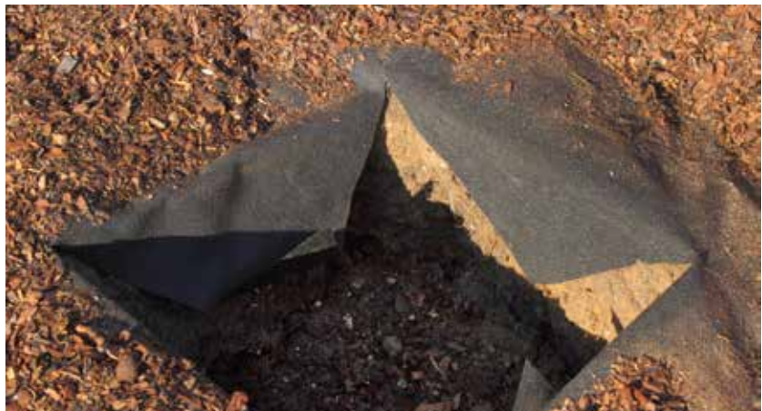
Посадка растений: сделать крестовые разрезы в геоткани, разместить в них саженцы, закрыть обратно края разреза и засыпать поверхность мульчей
